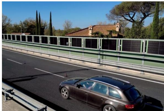
Ilustración 4. Imágenes 8 de proyectos fotovoltaicos desarrollados en carreteras en Italia y Alemania.
