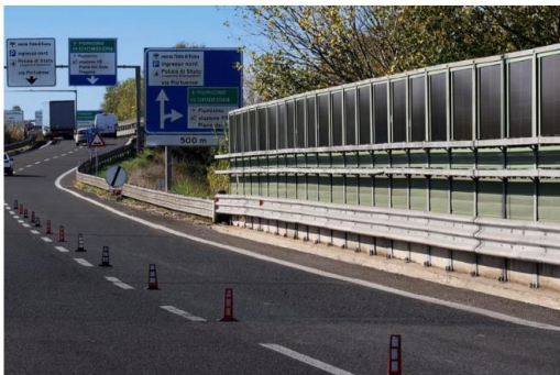
La empresa lituana Solitek ha instalado recientemente barreras acústicas fotovoltaicas en Italia. Imagen: Solitek
